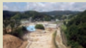
ほ場整備工事
