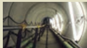
ライフライン推進工事
