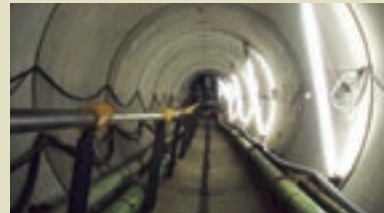
ライフライン推進工事
