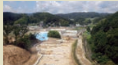
ほ場整備工事
